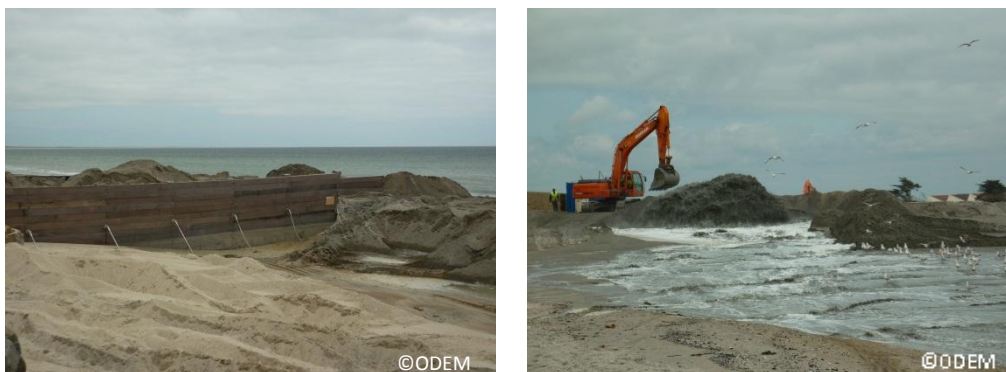
Figure 13 : Travaux de protection et de réhabilitation du littoral sur la grande plage de Gâvres en mai 2012 (à droite épis en bois azobé et à gauche ensablement de la plage)
